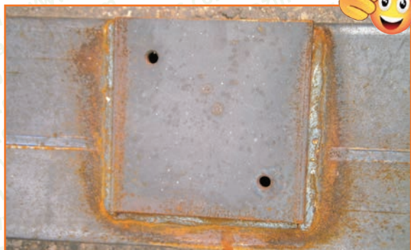
Photo 50 : Trous d'évent et soudure continue
