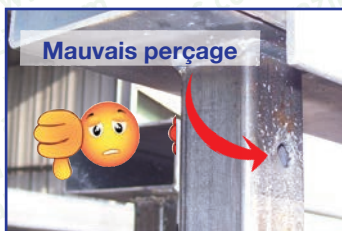
Photos 21 et 22 : Exemple de perçage près d'un angle
